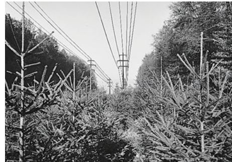
Schneise: Fichtenjungwuchs unter Hochspannungsleitung; Zufikon AG.
