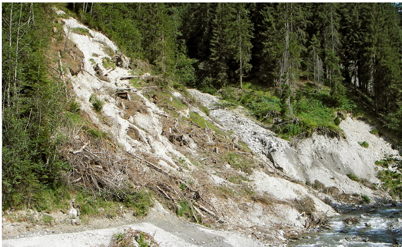
Der weitaus grösste Teil des Schutzwalds LFI4 dient der Minderung von Gerinneprozessen; St. Antonien GR.
