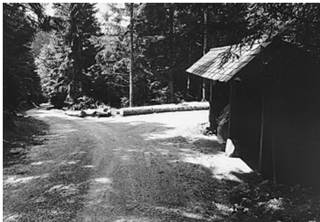
Dauernd nicht bestockte Waldfläche: Waldstrasse, Forsthütte, Kehr- und Lagerplatz; Süderen BE.
