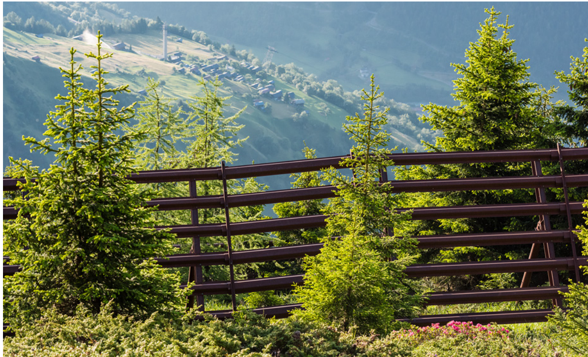
Neuer Schutzwald entsteht unter dem Schutz von Lawinenverbauungen; Riederalp VS.
