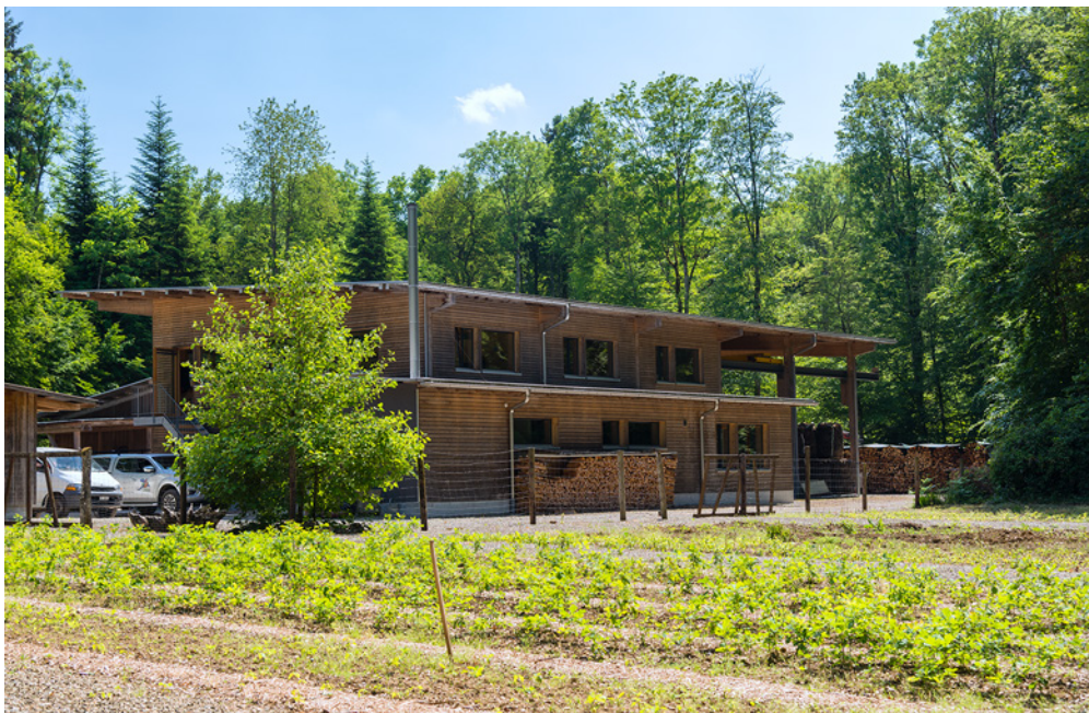
Grössere Forstbetriebe verfügen in der Regel über einen Werkhof; Ermatingen TG.
