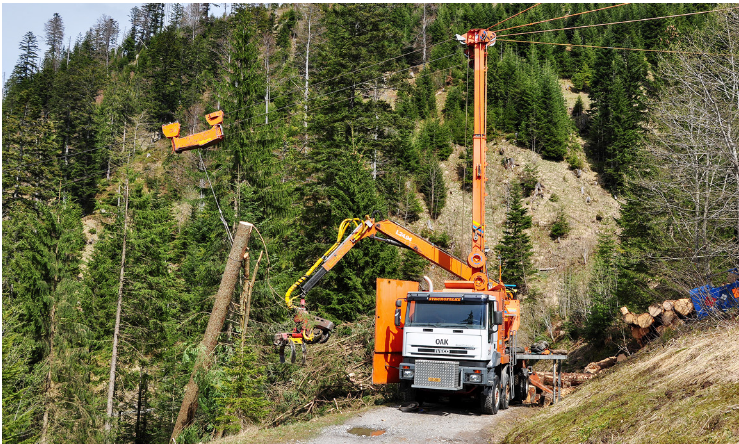
Im steilen Gelände kommen vermehrt Mobilseilkräne zum Einsatz; Rothenthurm SZ.
